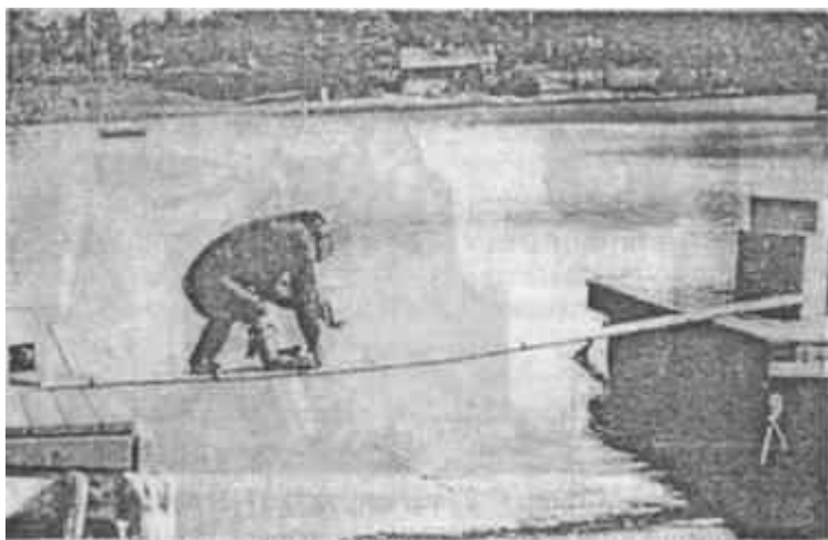
Рис. 4.11. Тушение огня на плотках (по Э. Г Вацуру, пояснения в тексте).
