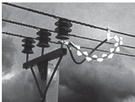
Рис. 4.5. Момент срабатывания разрядника РДИП-10
